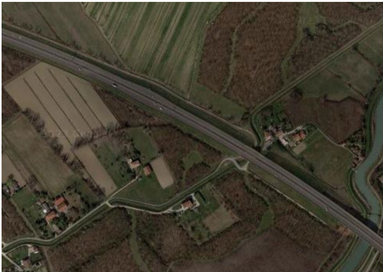
Figura 5. Zona intervento con barriera acustica al km 3+100 sulla tratta Raccordo Marco Polo.
