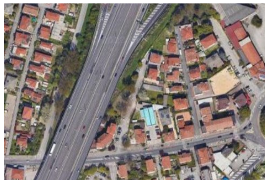
Figura 2 Edifici dal km 11+150 al km 11+300 ca in direzione Est
