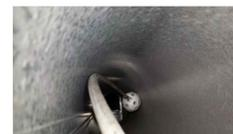
La soffiatura consiste nell'introduzione di un particolare robot filoguidato munito di ugelli collegati ad un potente compressore in grado di erogare 600 litri/min, questa caratteristica permette di sollevare e tenere in sospensione le micro-polveri non aderite al canale.
