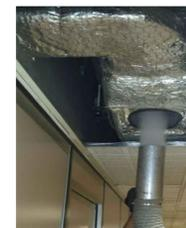
Dopo aver terminato le operazioni di pulizia verrà eseguita un'ispezione visiva mediante video ispettore degli impianti aeraulici per verificare che non sussistano evidenze residue di depositi visibili all'interno. Ad esito positivo dell'ispezione visiva, si provvederà a sanificare i canali nebulizzando specifici prodotti biocidi. La sanificazione dei canali permetterà di ridurre le future formazioni di funghi o batteri.
