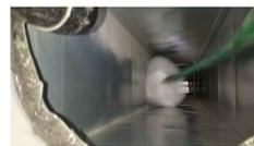
La spazzolatura consiste nell'introduzione di una particolare elettrospazzola dotata di speciali setole in nylon e polipropilene, adatte alle dimensioni ed alla forma delle condotte aerauliche interessate dalle operazioni di bonifica. L'elettro spazzola comandata da un operatore specializzato, ruotando solleva e tiene in sospensione il materiale polverulento che si trova all'interno delle condotte.
