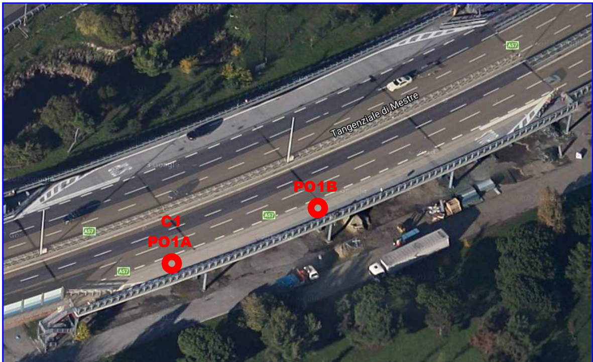
Piazzola di sosta n.2 – Carreggiata Est direzione Trieste
