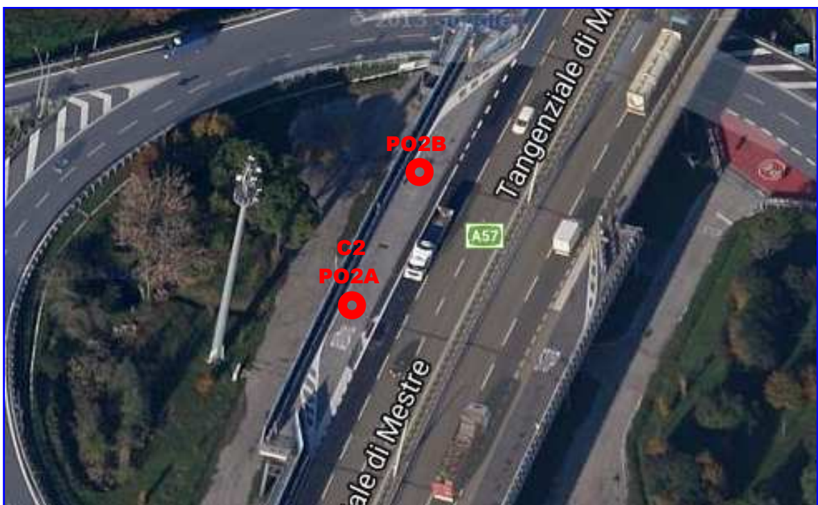
Piazzola di sosta n.5 – Carreggiata Ovest direzione Milano
