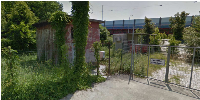
Cabina Zona Marghera
