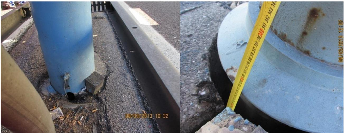
Per quanto riguarda l'incastro alla base si possono individuare sostanzialmente 4 tipologie di aggancio, diverse a seconda che il palo sia su rilevato (quindi innestato in pozzetto prefabbricato), oppure su viadotto, in cui il vincolo è costituito da profili di acciaio piuttosto articolati che sostengono un tubo flangiato su cui si innesta il palo.
