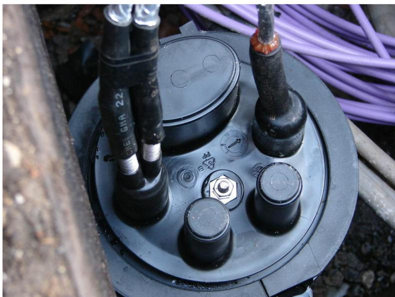
Figura 2 - Esempio di ingresso cavi alla base della muffola.
