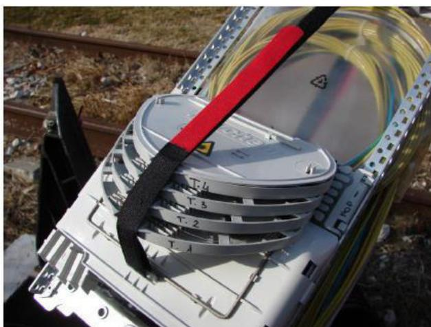
*Figura 3 - Muffola equipaggiata con moduli/schede di giunzione.*
