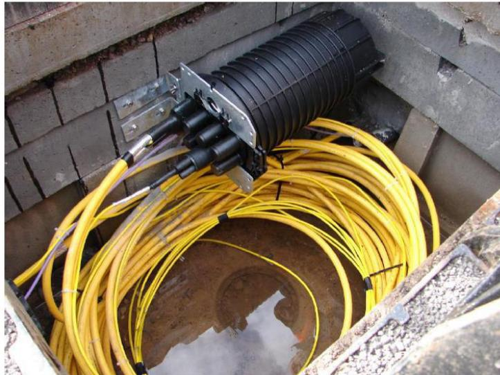
Figura 7 - Esempio di posizionamento muffola nei pozzetti
