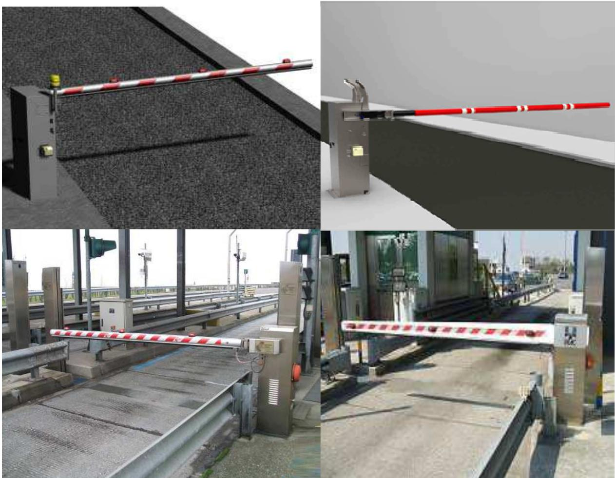
Fig.25 – Sbarre Chiudipista e Cadenzamento veicoli.
