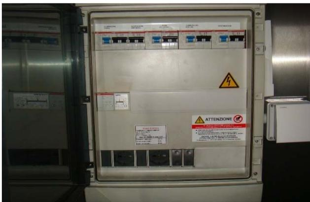
FIG.15 – PANNELLO DI REGOLAZIONE UNITÀ VENTILANTE
