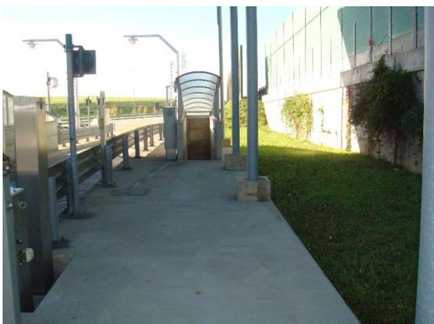
FIG.32 – POZZETTO DI ACCESSO AL CUNICOLO
