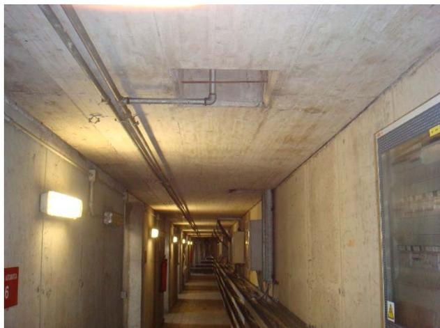
FIG.24 – FOROMETRIA PER PASSAGGIO IMPIANTI ELETTRICI
