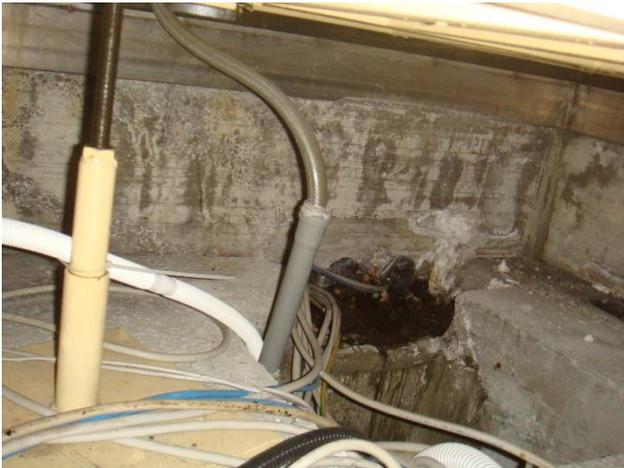
FIG.28 – PUNTO DI SALITA TUBAZIONI DIETRO FINTA COLONNA ESISTENTE
