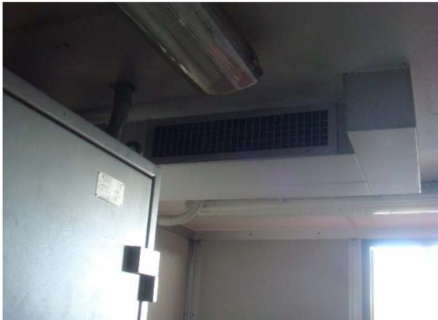
I canali dell'aria e le unità di ventilazione e trattamento sono raccordati mediante giunti in tela attraverso forometrie ricavate sulla copertura del prefabbricato, in posizione determinata dalle caratteristiche costruttive delle macchine, a loro volta posizionate su basamento metallico e poggianti su piedini antivibranti.
