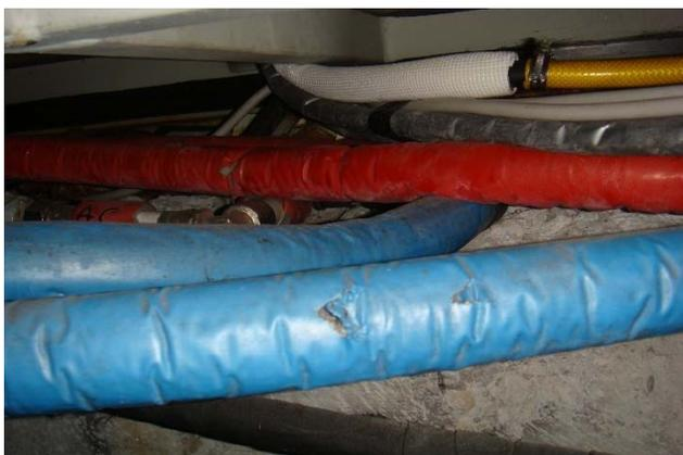
Oltre alle due tubazioni descritte, compiendo un percorso in cunicolo parallelo ad esse, sia nella cabina di esazione che nelle casse automatiche arrivano anche due tubazioni di acqua refrigerata, prodotta in modo centralizzato anche per gli attigui uffici da un gruppo frigorifero condensato ad aria della McQuay, modello McSmart 320 C, di potenza frigorifera nominale pari a 98,0 kW.
