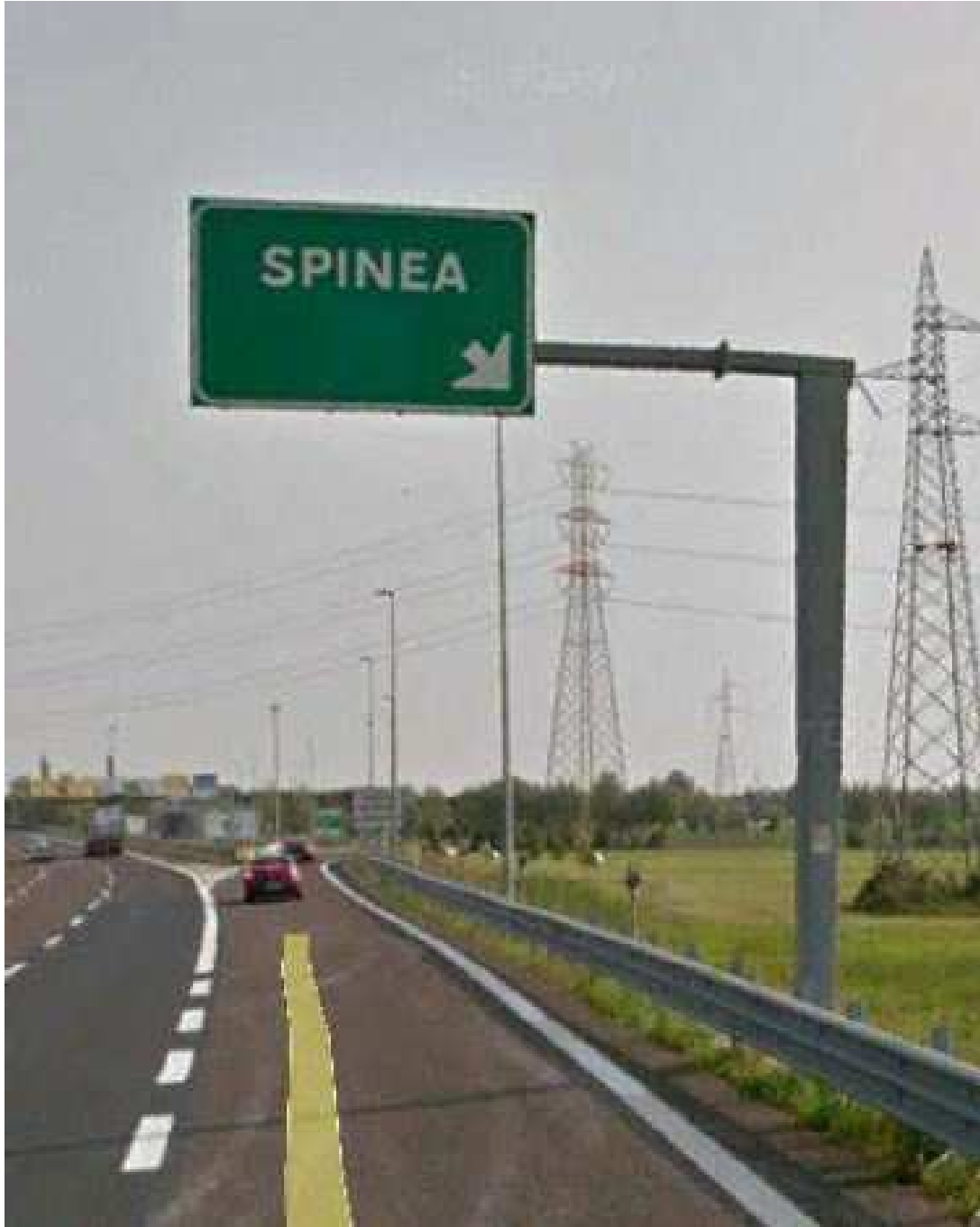
Figura 1 - esempio di portale a bandiera in A4
