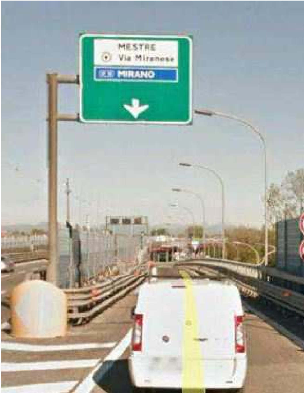
Figura 3 - esempio di portale a bandiera in A57
