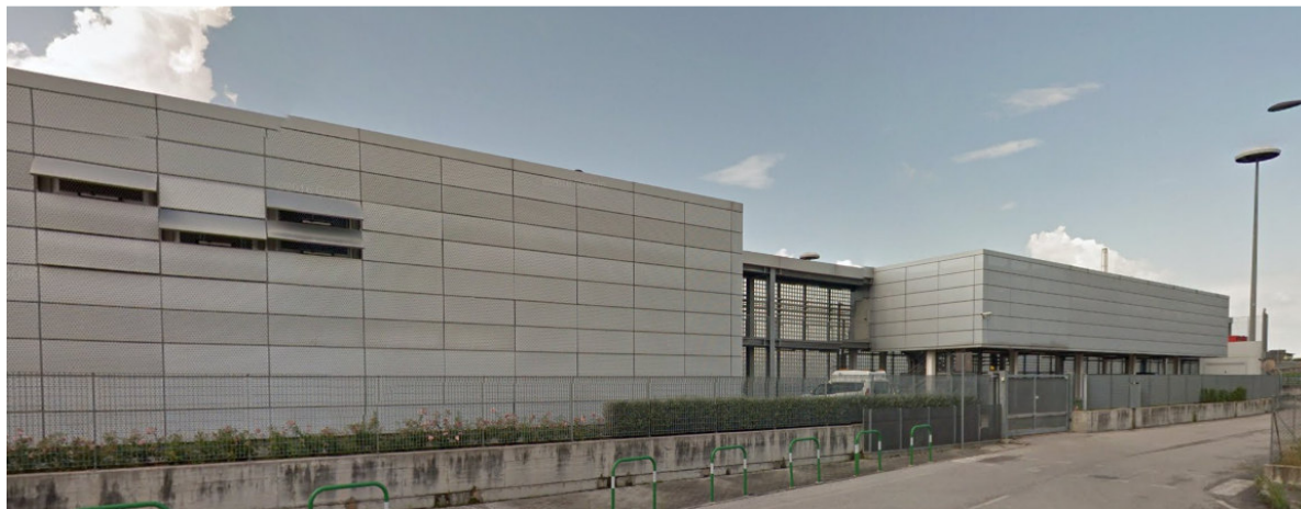
Vista lato sud dell'edificio, da via Canaletta
