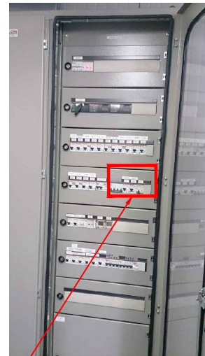
Posizionamento nuovo interruttore magnetotermico differenziale In=40A Trifase Idn=0,3A selettivo
