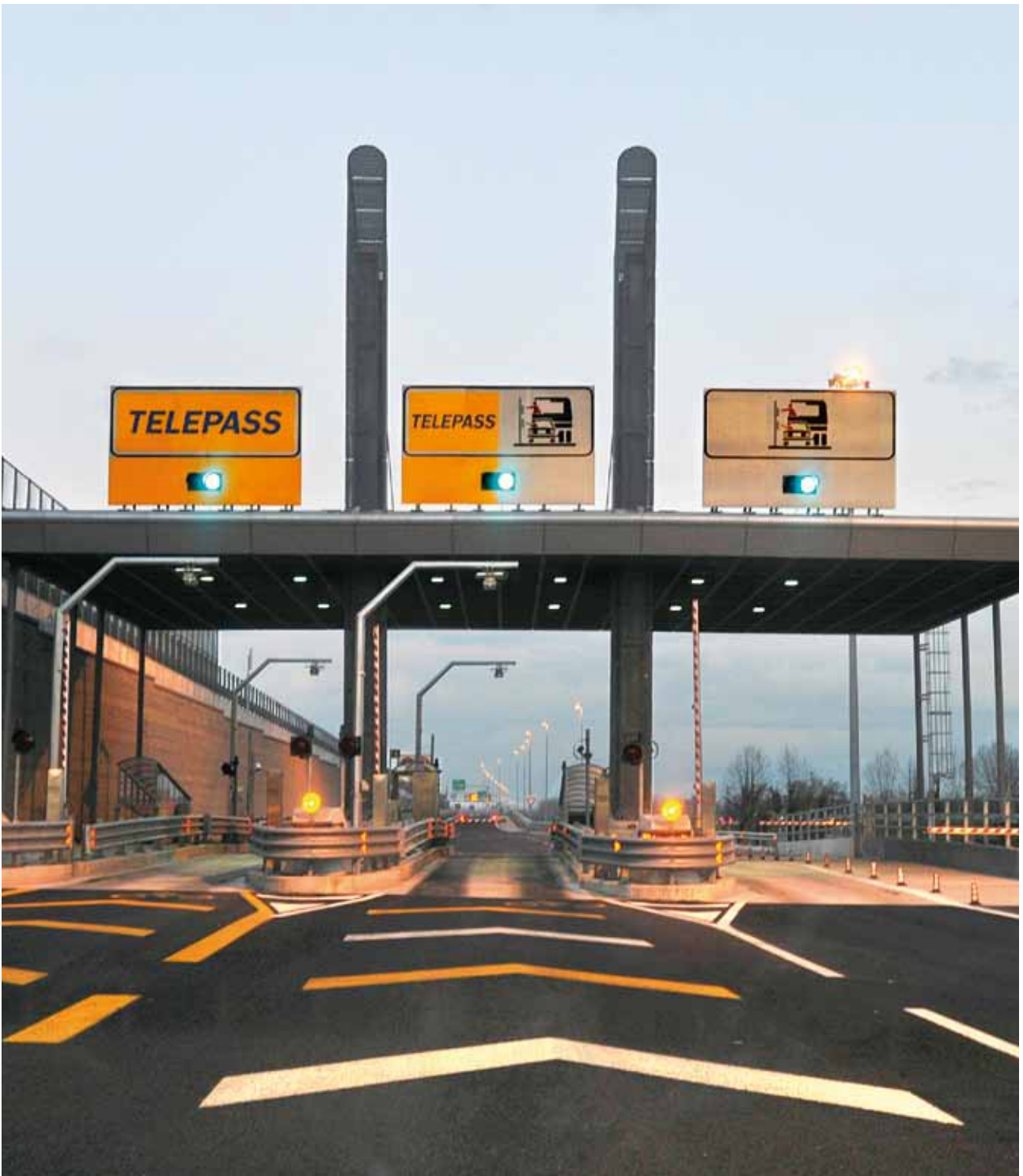
Linee essenziali, struttura snella. Il casello di Preganziol sulla A4 - Passante di Mestre, ad alta automazione.
