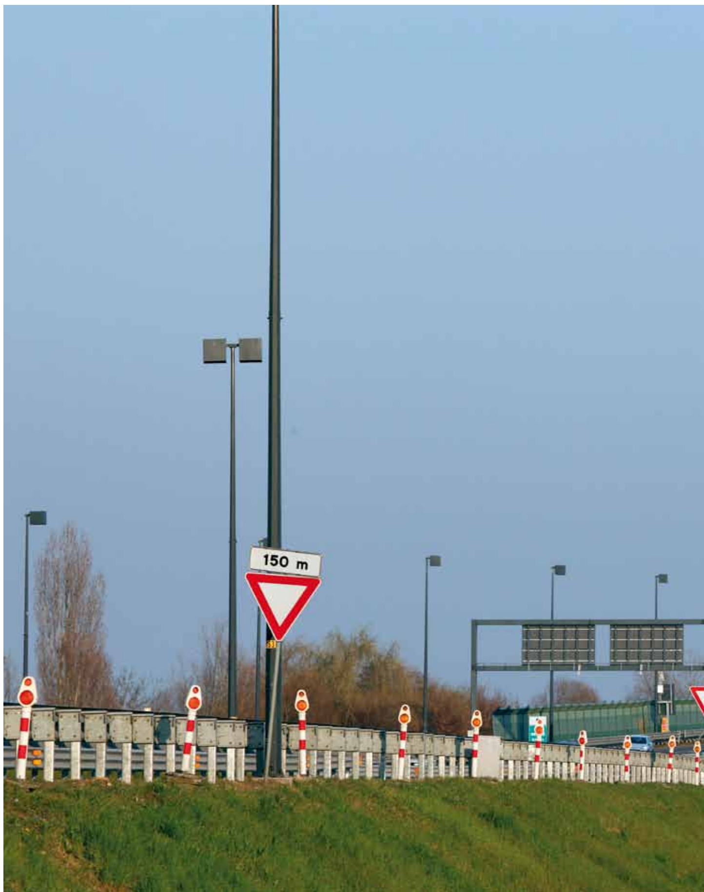
Il Raccordo Marco Polo. Misure di sicurezza. Oltre che le pavimentazioni, contano anche le dotazioni: barriere spartitraffico, barriere laterali, barriere fonoassorbenti, funzionali impianti di illuminazione, efficace segnaletica verticale, segnaletica luminosa, pannelli a messaggio variabile, colonnine sos.
