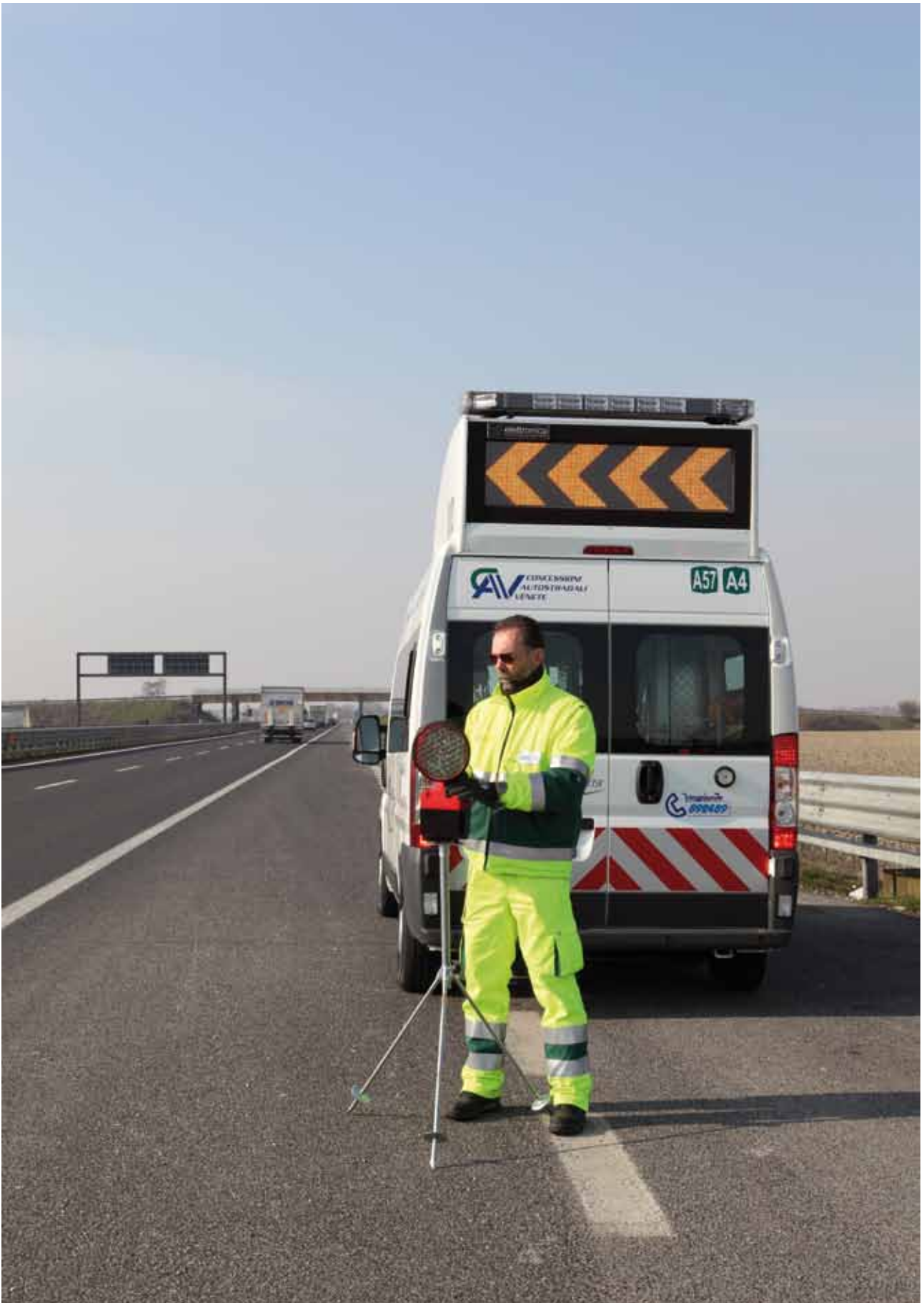
La segnaletica: così si comincia un cantiere.
