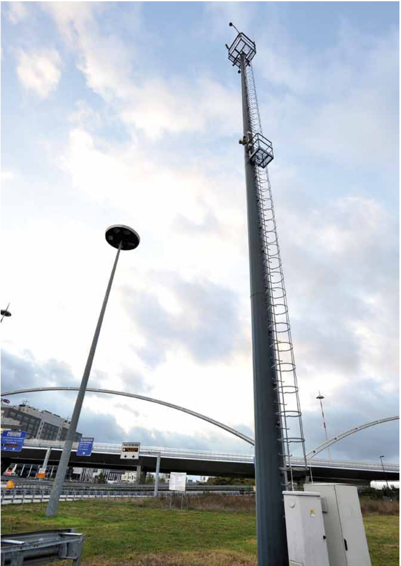
Il percorso di immissione a Padova Est sulla A4. Misure di sicurezza. Il lungo e sottile segno degli impianti per le telecamere. Il controllo visivo delle strutture consente alla CAV S.p.A. di gestire il traffico autostradale offrendo maggior sicurezza.
