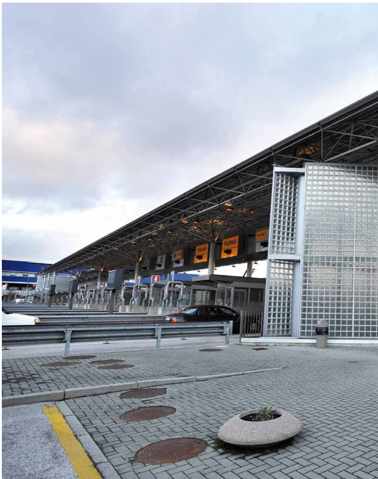
Padova Est. L'elegante volta della pensilina e l'ingresso del Centro servizi dove i clienti autostradali possono chiedere assistenza commerciale.
