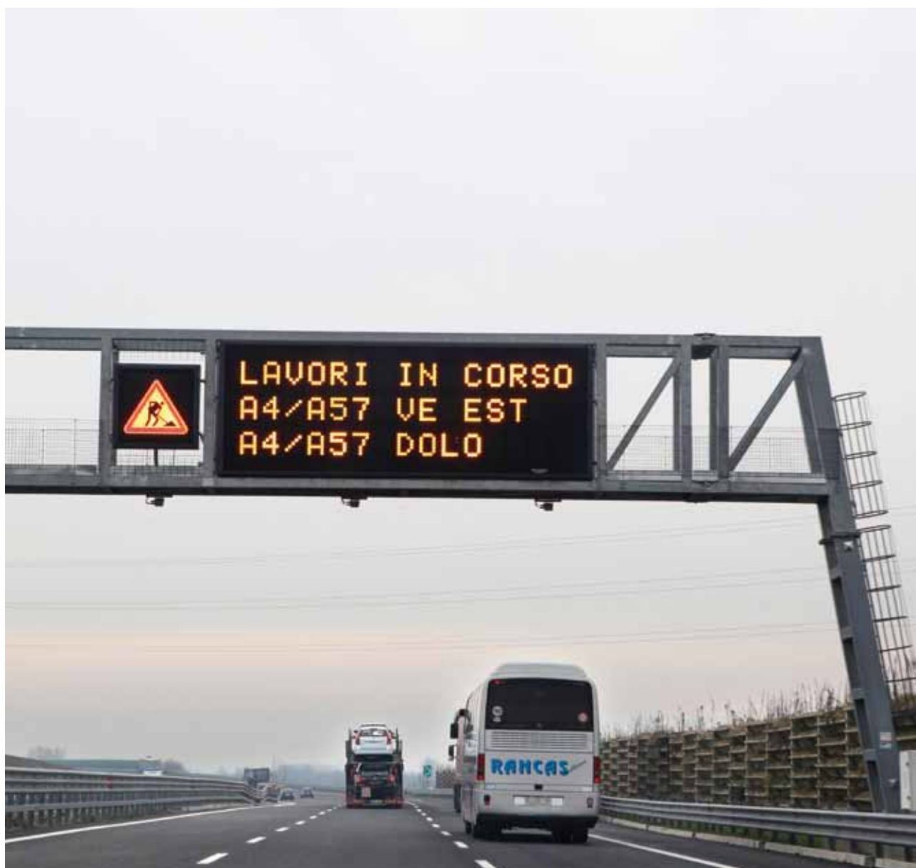
A4 nel tratto denominato Passante di Mestre. Portale con pannello a messaggio variabile e le barriere fonoassorbenti che consentono al Passante di inserirsi più armonicamente nel contesto ambientale.
