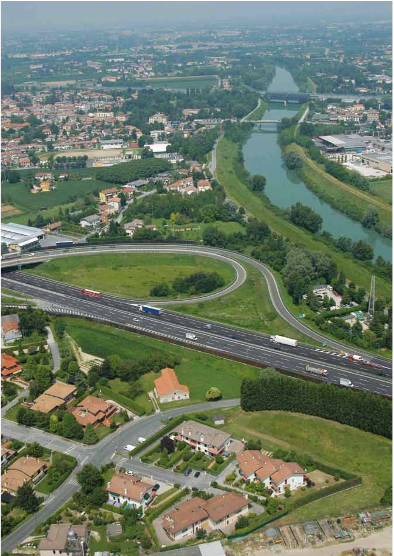
Nei pressi di Padova Est. Lo svincolo verso il sud, l'innesto sulla A13, riflette a specchio l'ansa del Brenta.
