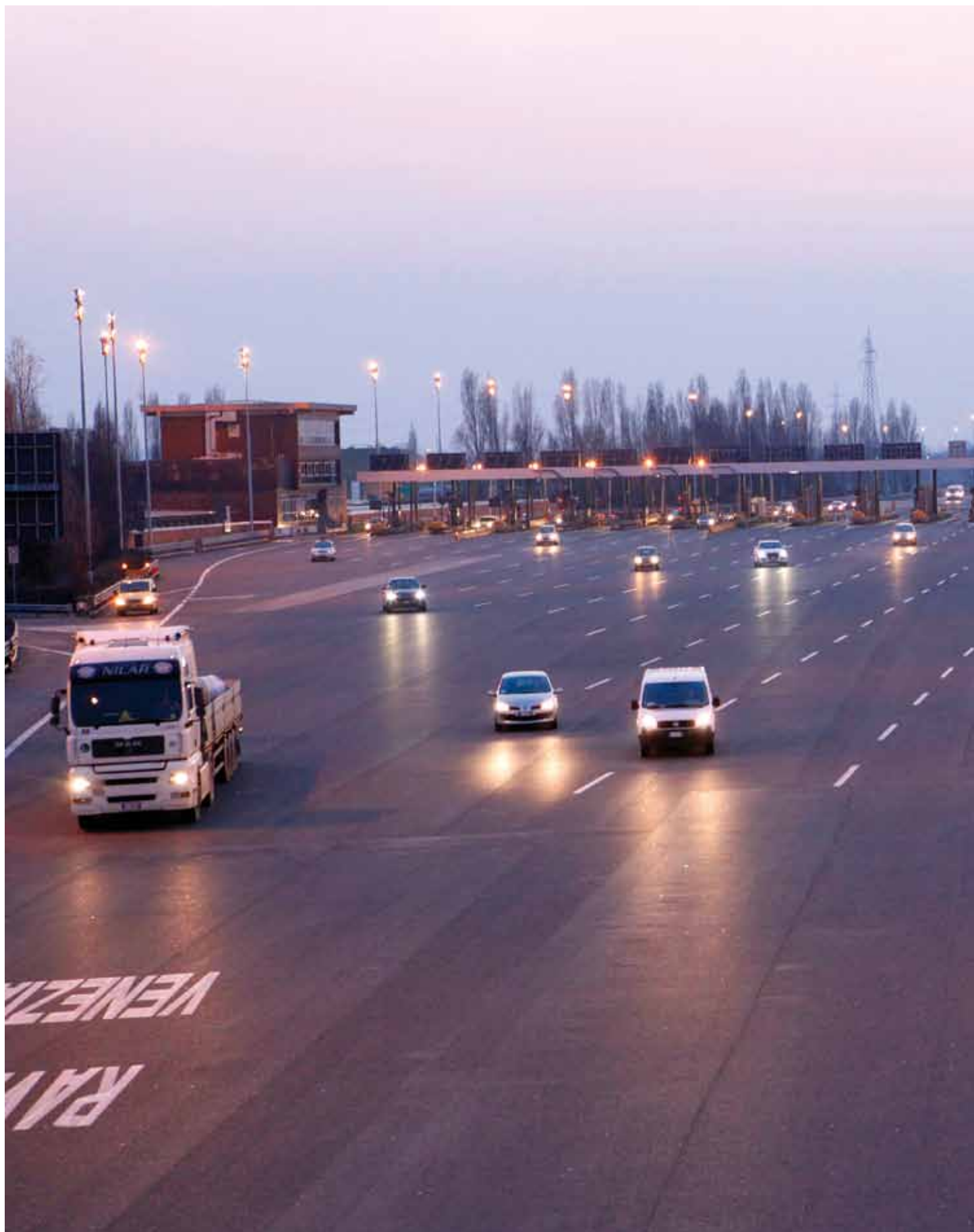
A57 Barriera di Venezia-Mestre. L'ora tarda non rallenta il traffico. La CAV è impegnata ad offrire continuità di servizio.
